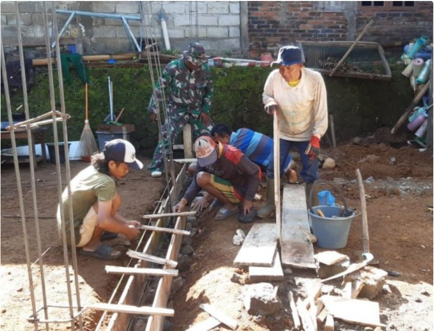
Pemasangan Bekisting Balok Sloof
